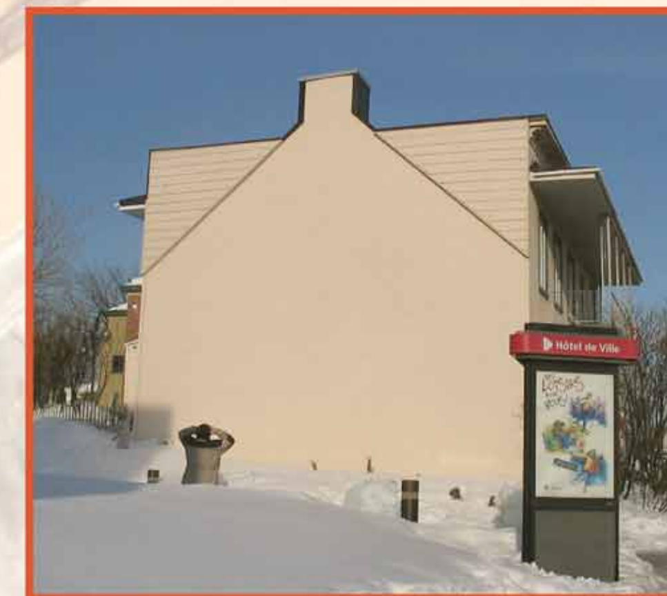
Le mur avant la réalisation
